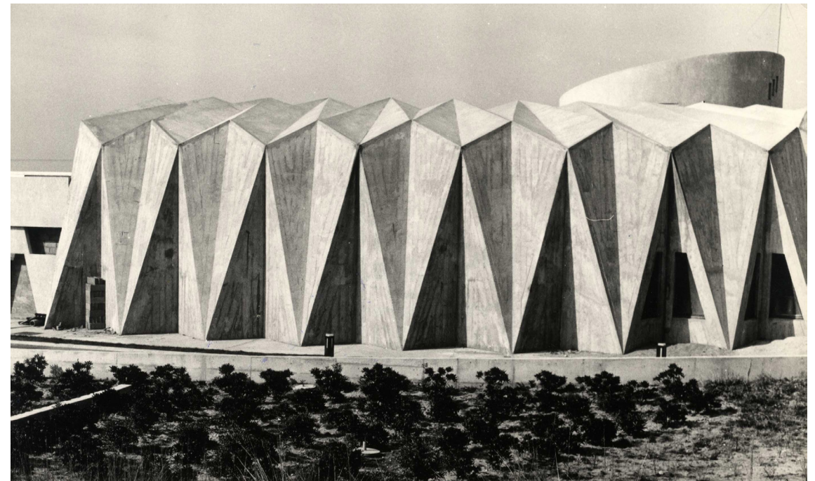
Côté est, une magnifique coquille de béton, vient se replier sur le bâtiment. Le projet de restaurant initialement prévu sous cette toiture origami ne fut jamais réalisé.
