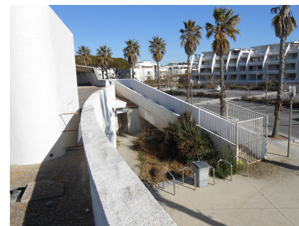
Ici, des volumes sont venus obstruer le dessous de la passerelle, annulant son effet de décolllement.
