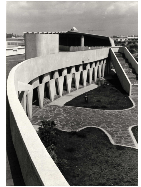
La façade vitrée du bâtiment est en retrait de la façade moucharabieh de béton, créant un entre deux frais et ombragé. Un jeu de plaques en pierre de Lodève rouge guide le visiteur et sculpte le sol
