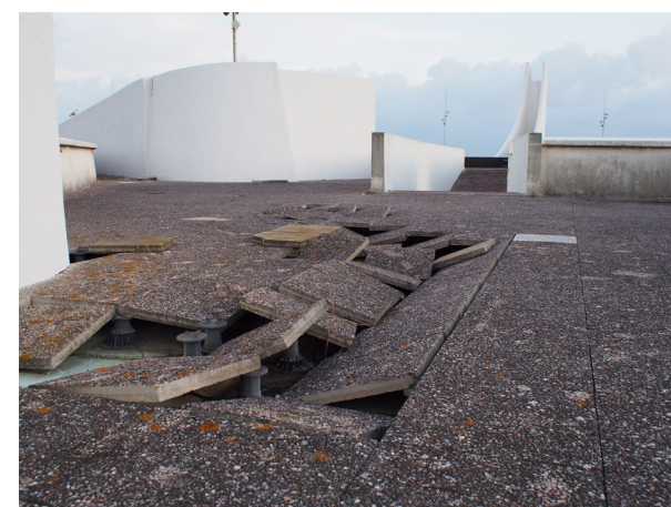
La terrasse sur le toit est actuellement inaccessible
